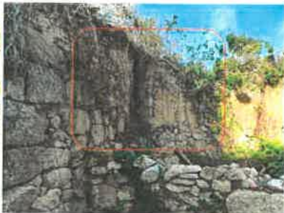
Troço deformado (vista exterior e interior).
