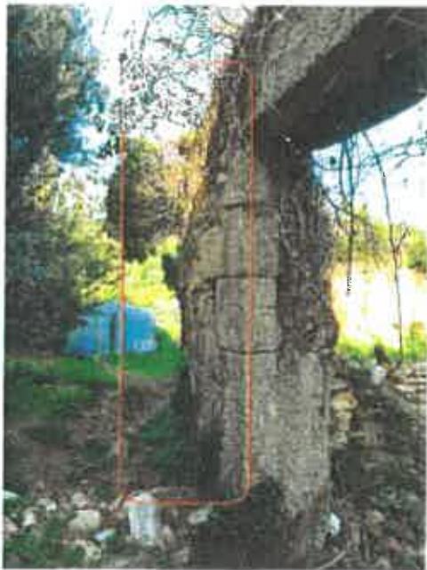
Troço deformado (vista exterior e interior).
