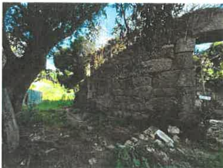
Troço deformado (vista exterior e interior).
